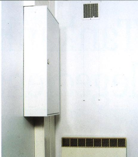
Die komplette elektrische Steuerung der Dieseltankanlage ist zugriffssicher und übersichtlich untergebracht. Aber KNAUSS denkt für Sie weiter. Die Stromversorgung erfolgt über einen zentralen Verteilerschrank. So bietet sich Ihnen die Möglichkeit, weitere elektrische Verbraucher für die Tankanlage anzuschließen, wie z. B. Platzbeleuchtung, Druckluftanlage oder elektrische Torantriebe.
