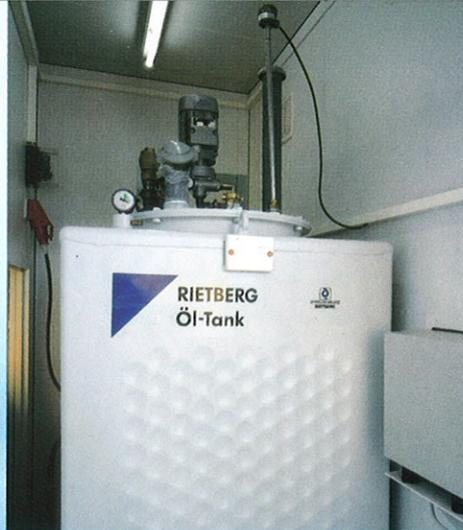
Für die Versorgung Ihrer Maschinen und Fahrzeuge mit Motorenöl steht eine komplette Ölabgabestation zur Verfügung. Der Tank entspricht den Vorschriften des WHG und bietet eine ausgezeichnete Umweltsicherheit durch die doppelwandige Bauweise mit akustischer und optischer Leckanzeige. Sein Fassungsvermögen beträgt 1000 Liter.
